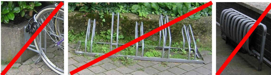
Abbildung 5-7: Reine Vorderradhalter sind keine geeigneten Fahrradabstellsysteme
